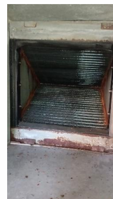
Serpentín Unidad Evaporadora (Después del Mantenimiento)
