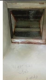
Serpentín Unidad Evaporadora (Antes del Mantenimiento)
